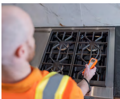
Verificação de um fogão a gás propano
