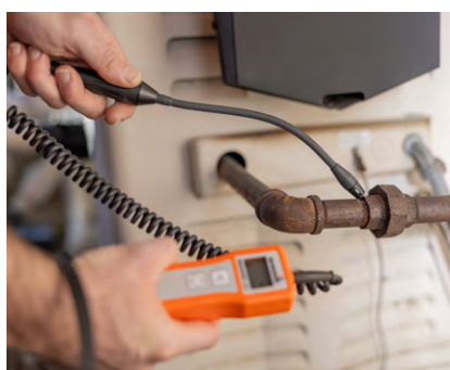
Verificação de um aquecimento a gás
