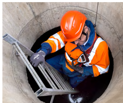
Pomiar w studzienkach
