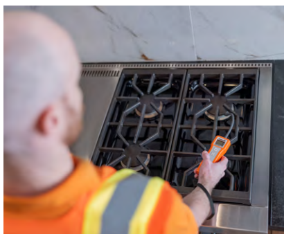
Contrôle d'une cuisinière à gaz propane
