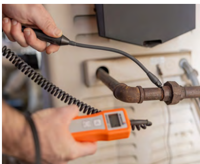
Contrôle d'un chauffage de piscine au gaz
