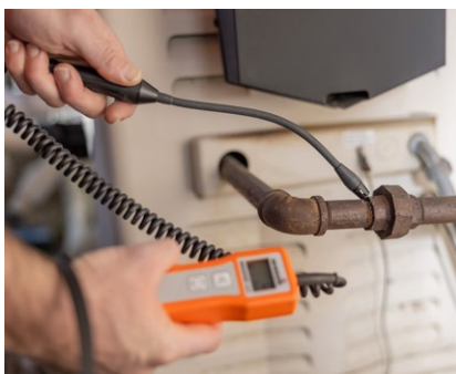
Inspección de sistemas de calefacción de piscinas a gas
