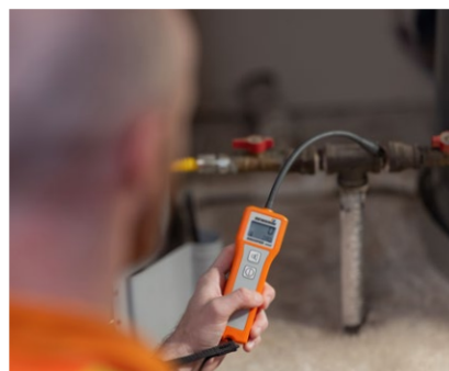
Inspección de una instalación de calefacción
