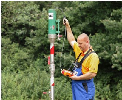
Gas messen im Einsatzfall Spülen zum Nachweis von Gasreinheit/Gasfreiheit
