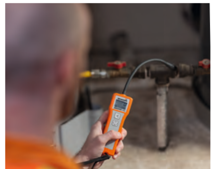
Überprüfen einer Heizungsanlage
