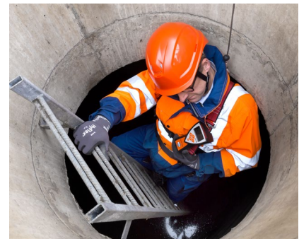
Freimessen von Schächten
