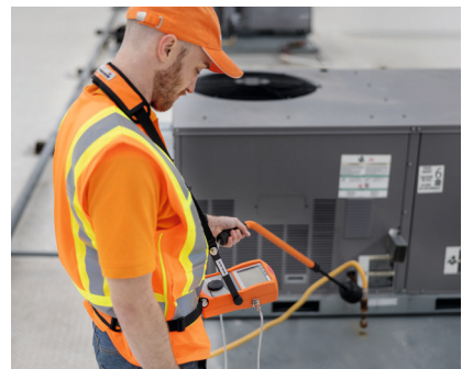
Prüfung auf Gasindikationen
