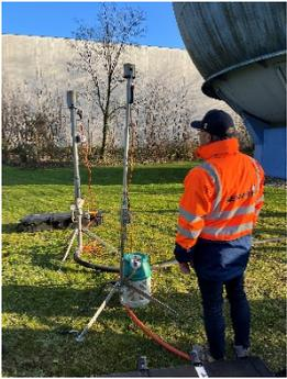
Restgasmengen sollten zwingend aus dem Bereich einer gesperrten, stillgelegten oder mit neuem Medium befüllten Versorgungsleitung entfernt werden. Für eine umweltbewusste Unternehmensphilosophie sollten diese abgefackelt werden, um so Methanemissionen zu vermeiden.
