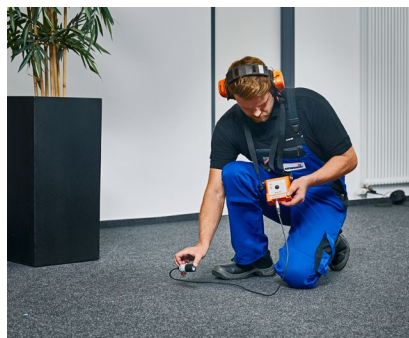
Leitungsortung mit dem Empfänger AF 50 und der Suchspule SK3
